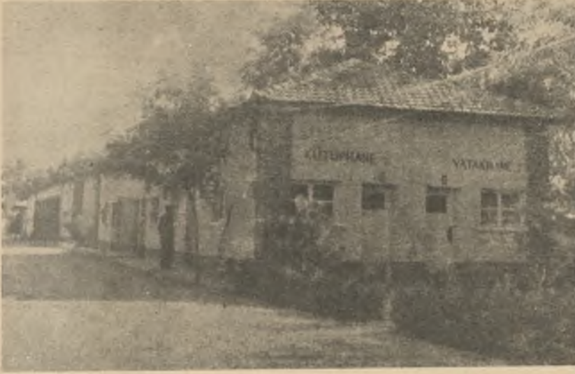
Modern tess'leriyle bölgeye faydası dokunan kara yollarından bir görünüş...
